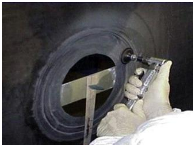
그림 10 실제 구조물에 적용하는 스카프 수리 예시
